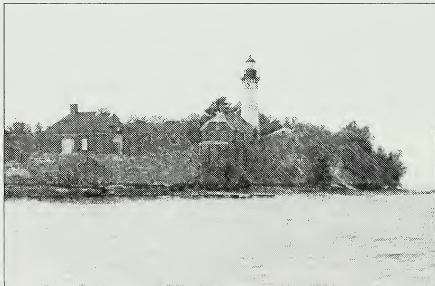
Au Sable Light Station
