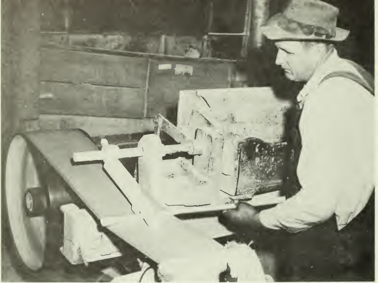
Figure 9. --Sanding axe handles.
